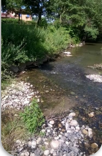
Berge restaurée 6 mois après les travaux
